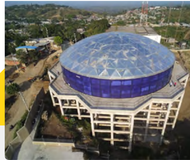
Sistema de almacenamiento de 8.000 m 3 de agua potable Sincelejo, Sucre. Colombia
