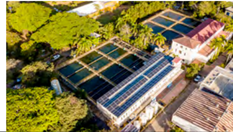
Planta de tratamiento de agua potable del Bosque. Aguas de Cartagena - ACUACAR Cartagena, Bolívar. Colombia
