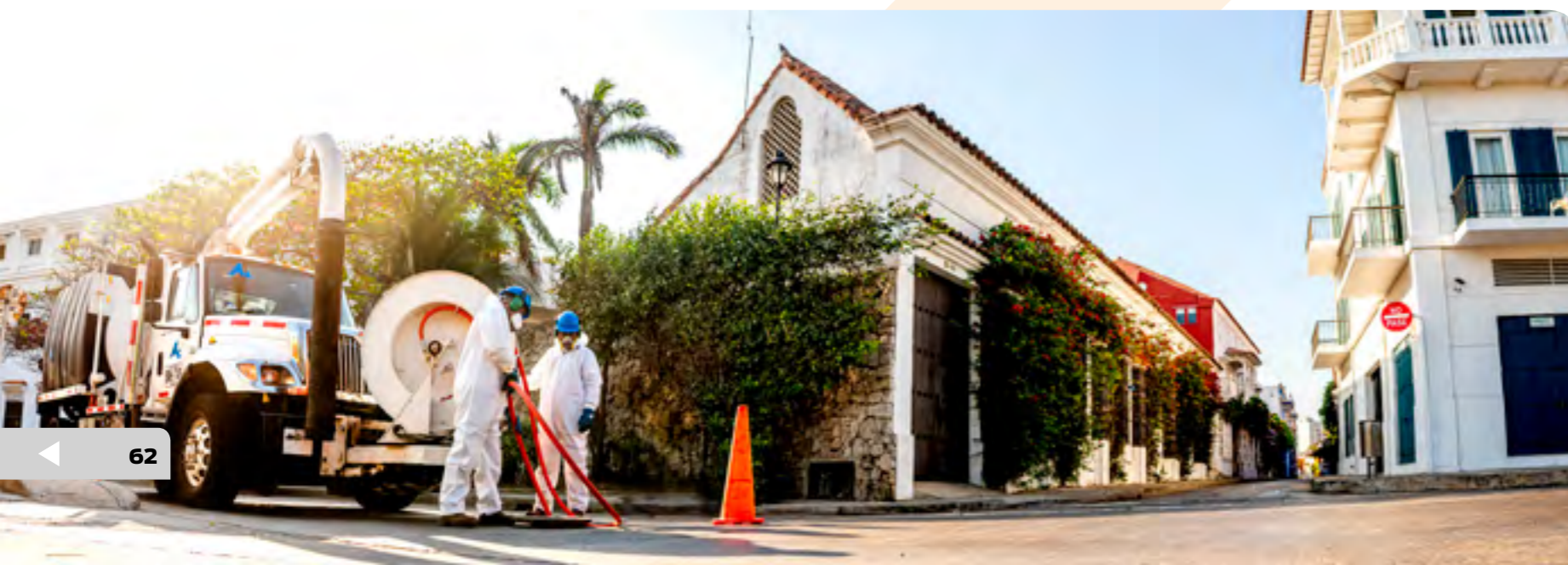
Limpeza y sondeo de alcantarillado Cartagena, Bolívar. Colombia
