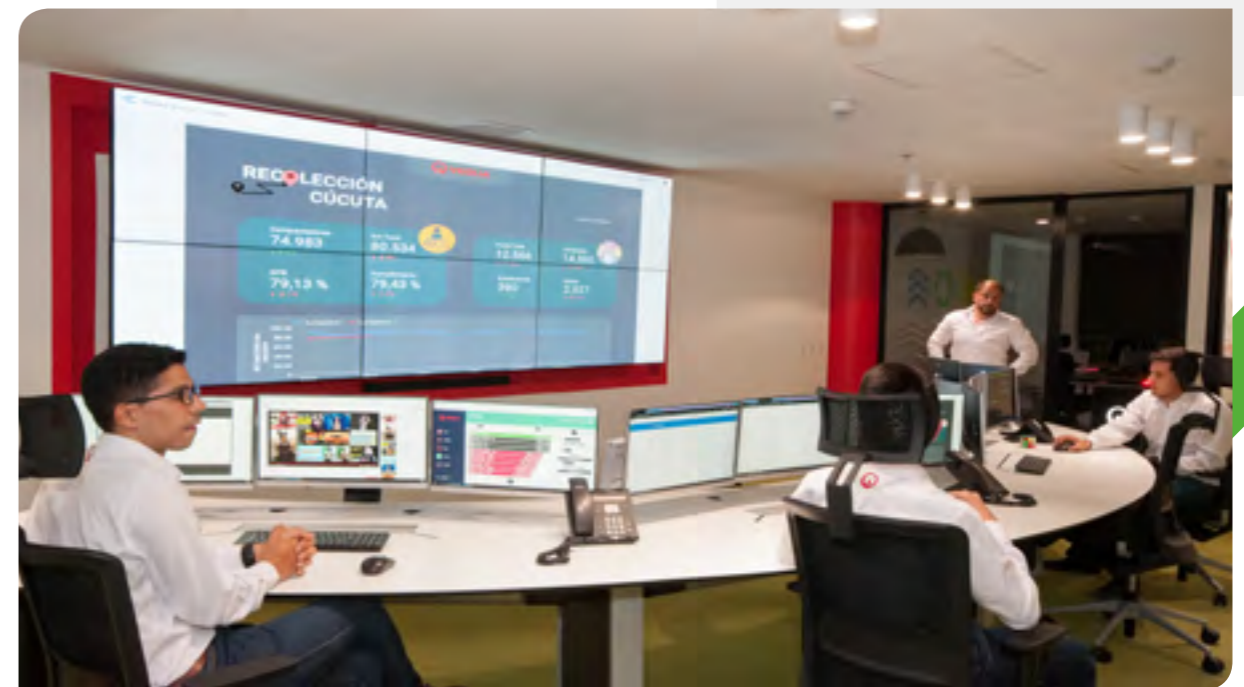
Centro de control y monitoreo HUBGRADE Bogotá, Colombia.
