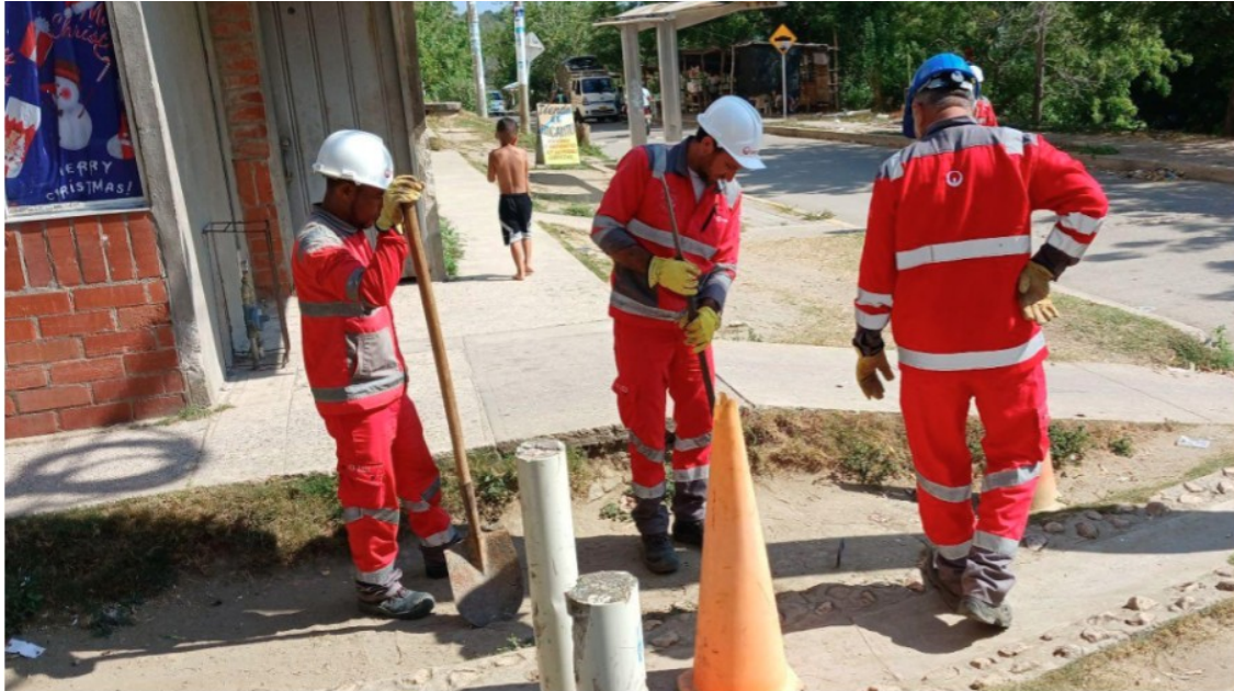
Inspección al sistema de alcantarillado
